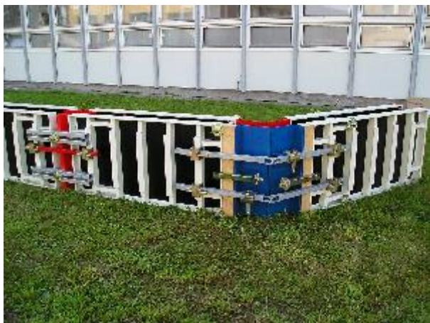
Obr.č.3 Montáž bednění do výšky 75 cm
