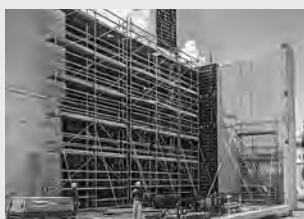
Pracovní lešení na staveništích
